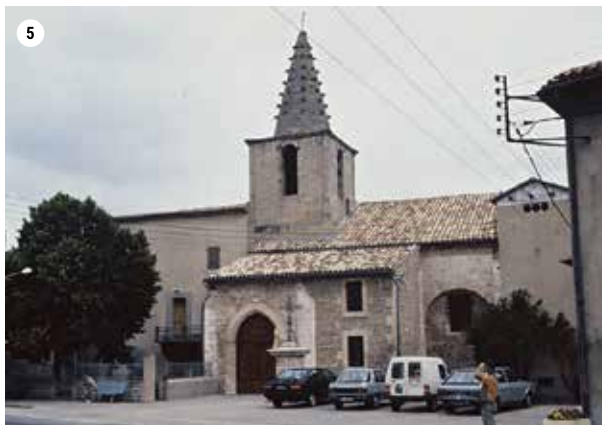
1990 - Photographie Couverture en tuile des toitures pierre; mise à nue des moellons en façade; suppression de l'enclos devant l'entrée; parking.
