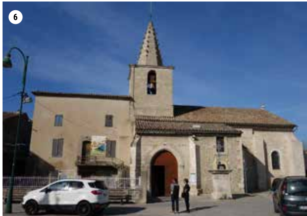
2019 - Photographie Etat actuel: disparition des arbres, démolition du poste électrique & de la bâtisse sur rue
