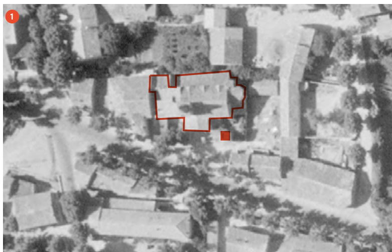
1947 - Photographie aérienne Disposition de l'îlot quasi similaire à celle du 17/18 e siècle. La cour du chevet est toujours présente. Construction d'un poste électrique devant l'église
